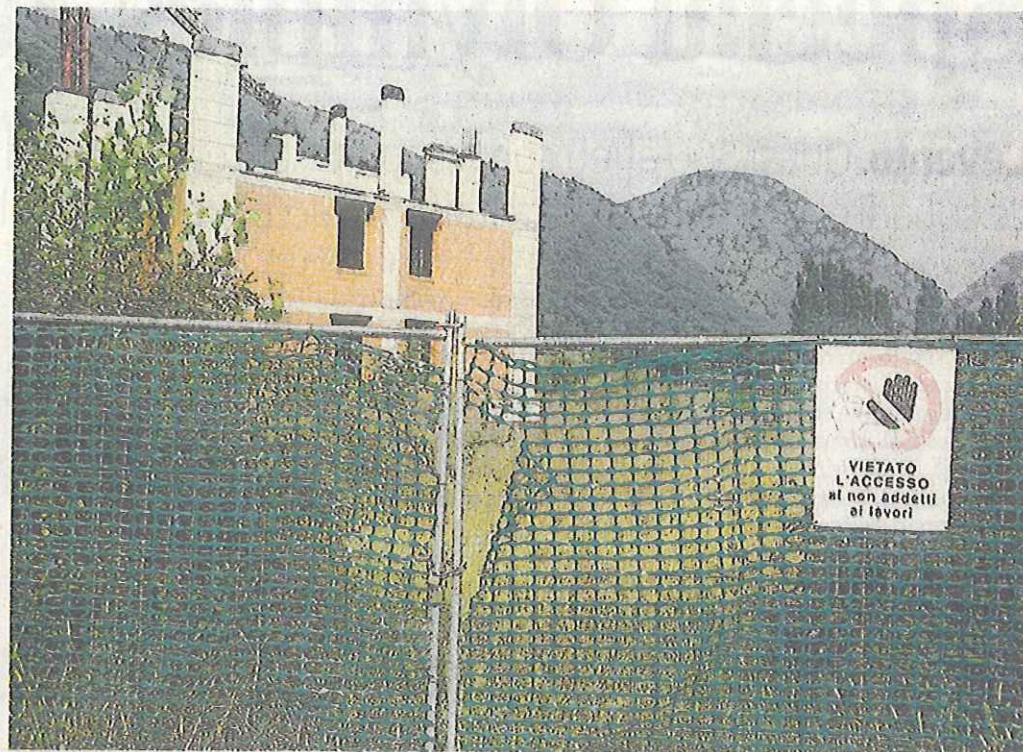
Il cantiere delle case Aler: i lavori riprenderanno in tempi brevi
