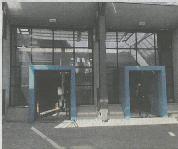
Wall Street in via Belfiore, i nuovi locali dopo la ristrutturazione
