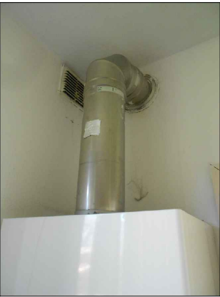
Foto 13 - Canna fumari caldaia
